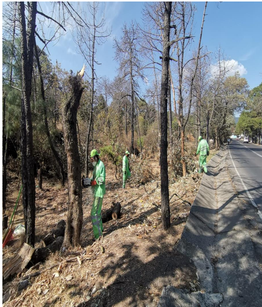
DERRIBO Y TROCEADO SUJETO FORESTAL
